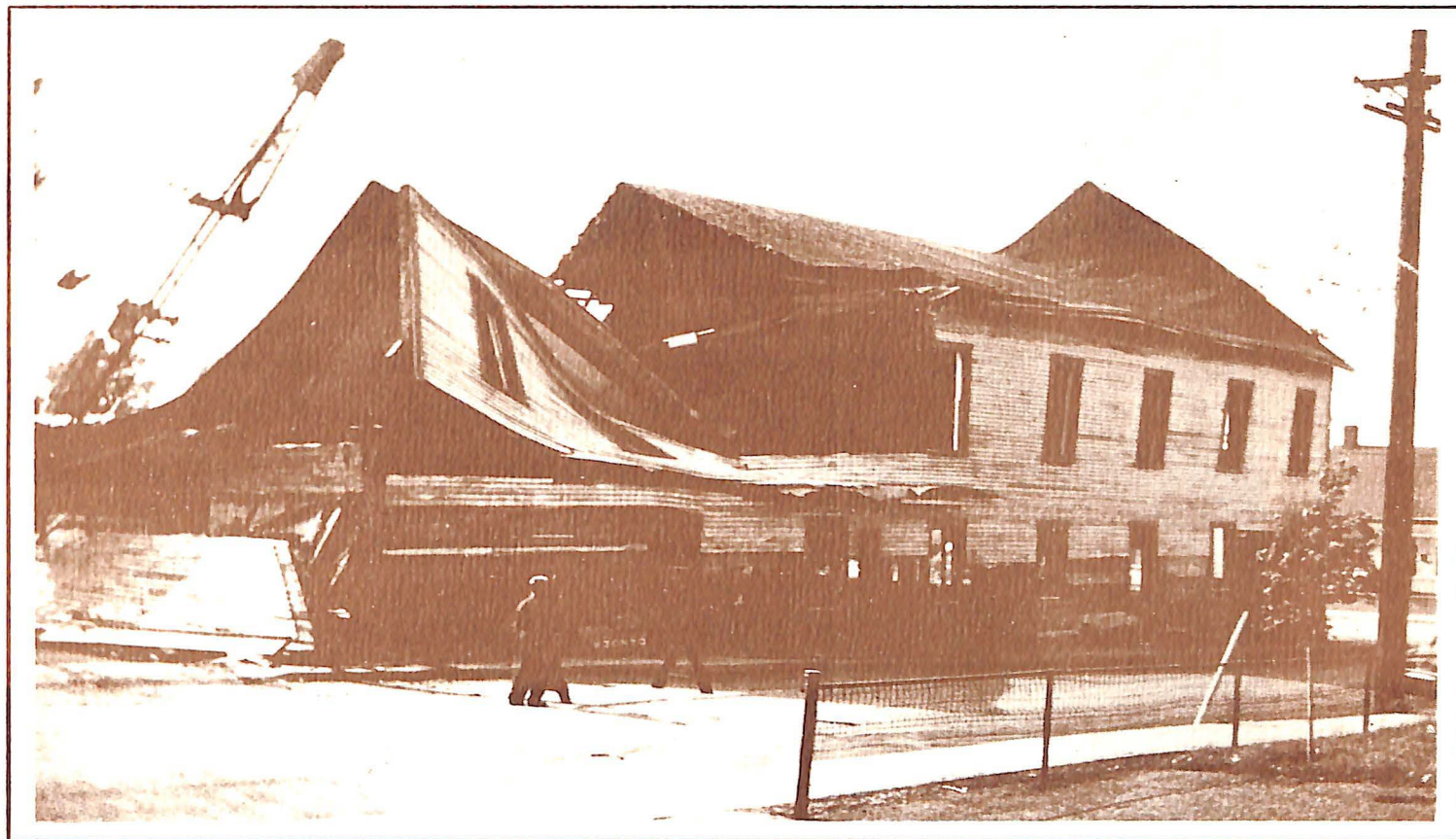
Démolition de la salle des bazars
