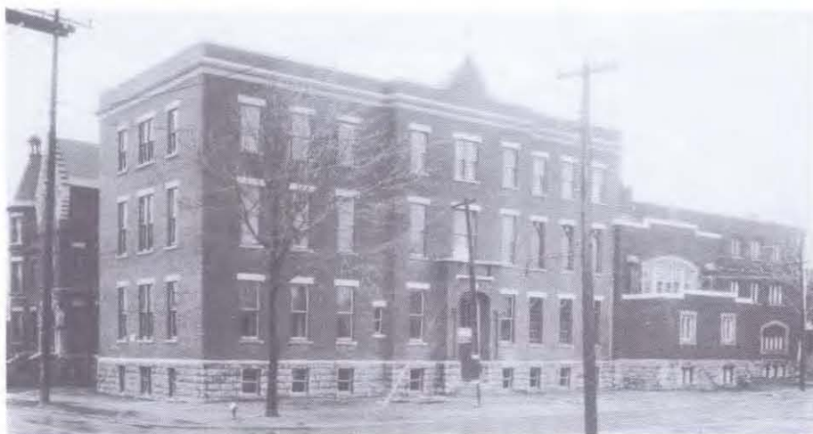
À GAUCHE: L'aile de l'est à l'angle des rues York et Water, construite en 1928 et rattachée au couvent de 1914 (à droite). La tourelle de l'aile de 1901 paraît à l'extrême gauche. DESSOUS: En 1938, l'Hôtel-Dieu, avec entrée sur la rue Water, comprenait une aile à l'ouest (à gauche) et une aile à l'est (à droite). En 1992 les Appartements Marie-de-la-Ferre y furent aménagés.
