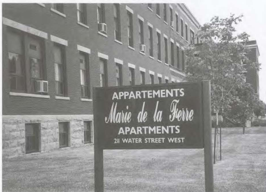
En 1992, la Société de logement des RHSJ convertit l'ancien hôpital Macdonell Memorial en appartements sans but lucratif afin de loger des citoyens âgés. Le projet de 4,4 millions de dollars comportait 59 appartements, dont six sont pour personnes handicapées. Un corridor couvert relie cet édifice à la Villa Saint-Joseph. (Photo de Anne Vincelli)
